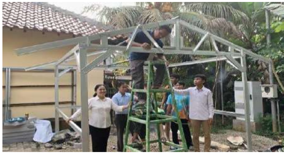
Gambar 1. Pemasangan Rangka Greenhouse
