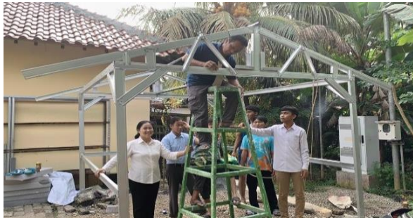
Gambar 1. Pemasangan Rangka Greenhouse
